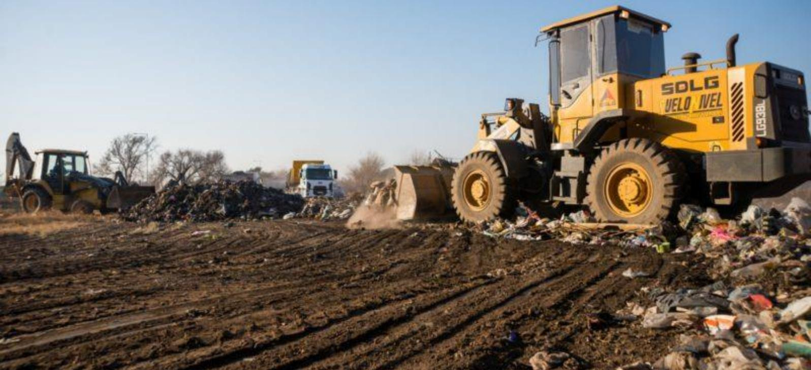
De los canales pluviales, se retiran residuos con 1 retro pala, 1 minicargadora, 1 camión de 6 m<sup>3</sup> y otro de 25 m<sup>3</sup>, además de 4 operarios por zona (sur y norte) realizan tareas de desmalezado y limpieza en forma manual.
